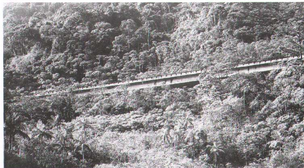
Monumento ao desperdício. Viaduto em trecho não concluído da BR-101 Foto: Adriana Coutinho/Fundacc
